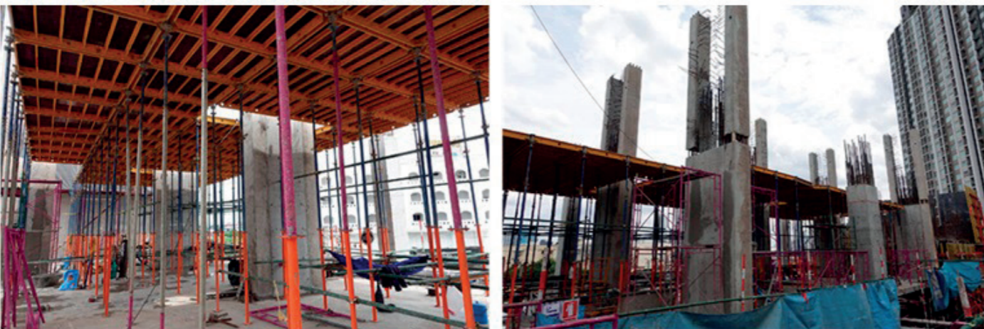
รูปที่ 7 การทำพื้นที่อยู่ในส่วนที่สองของเสาสำเร็จรูปที่เตรียมเว้นช่องว่างรอยต่อระหว่างชั้นไว้
