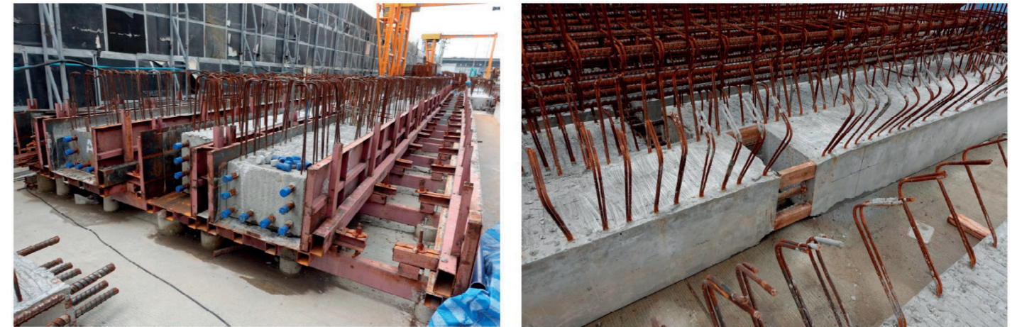
รูปที่ 4 การหล่อชิ้นส่วนของเสาสำเร็จรูป
