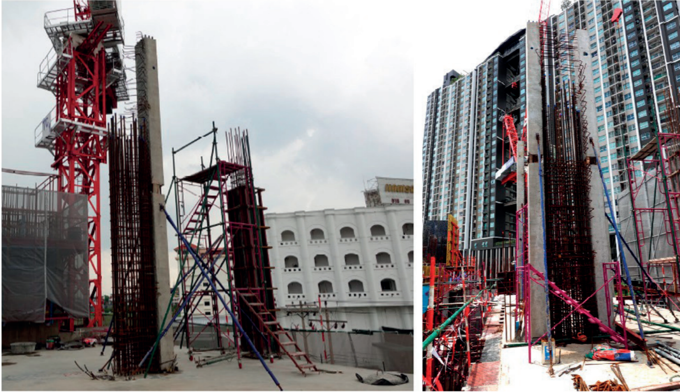
รูปที่ 6 นำเสาสำเร็จรูปมาติดตั้งประกบทั้งสองด้านของเหล็กเสริมเสาส่วนที่หล่อในที่
