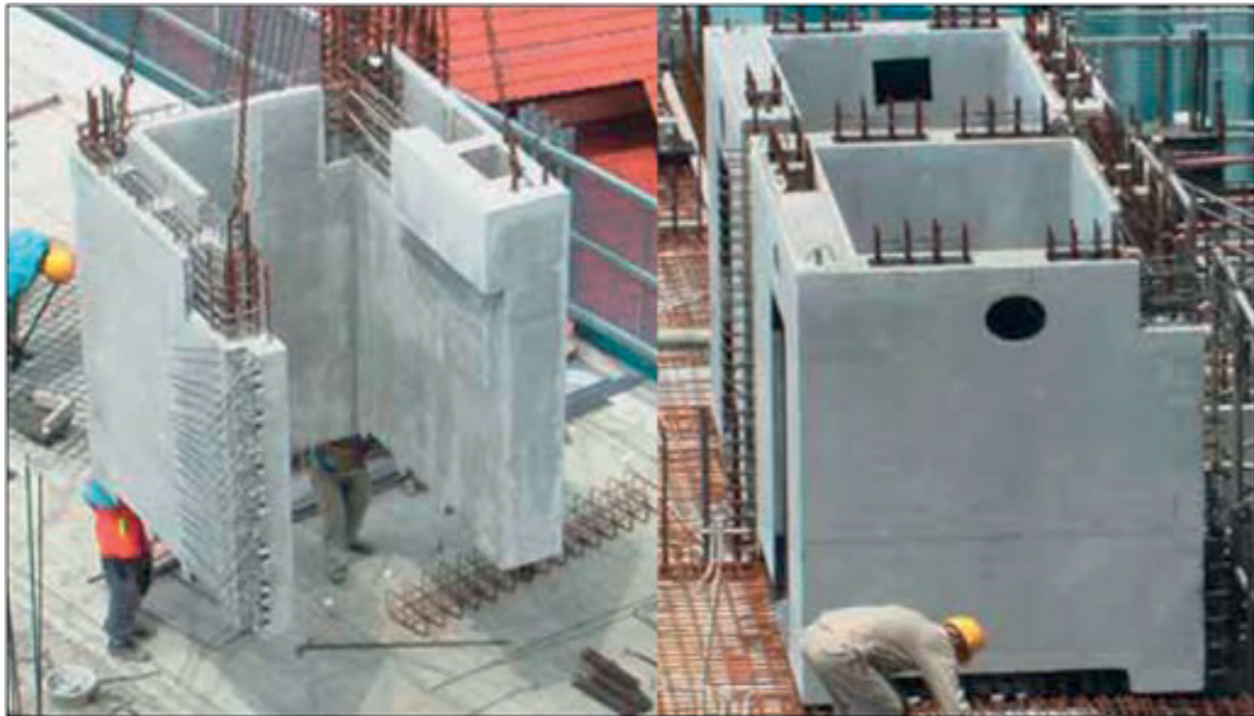
รูปที่ 10 ผนังแบบแกนกลวง (hollow-cored)
