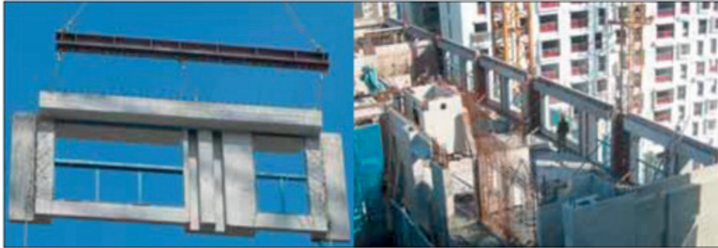
รูปที่ 9 ผนังเปลือกอาคารมีความยาว 7 ม.
