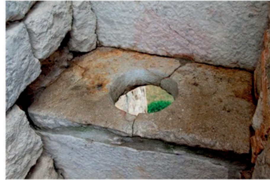
รูปที่ 4 Keiss Castle ในสกอตแลนด์ที่สร้างติดหน้าผา ห้องส้วมปล่อยของเสียทิ้งลงสู่หน้าผา
